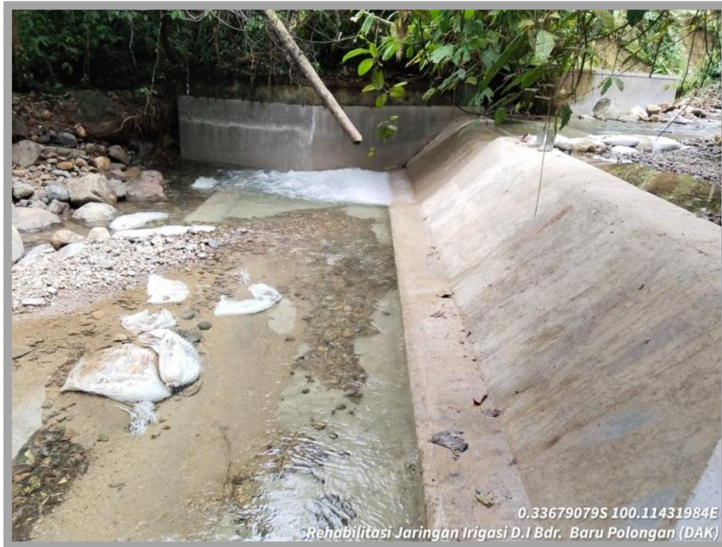
Rehabilitasi Jaringan Irigasi D.I. Bdr. Baru Polongan
