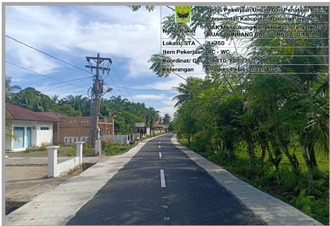
Rehabilitasi Jalan Ruas Gunung Basi – Sungai Gimbar
