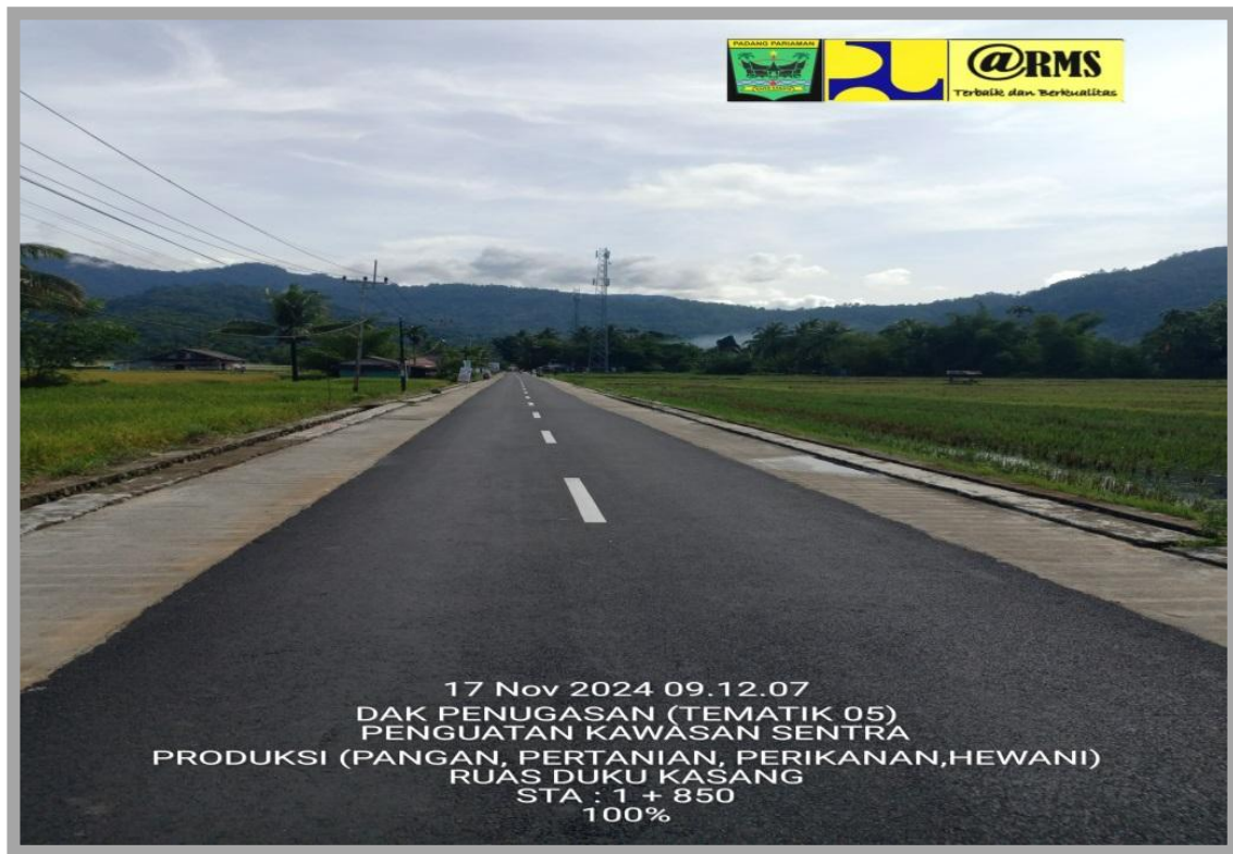
Rehabilitasi Jalan Ruas Duku – Kasang
